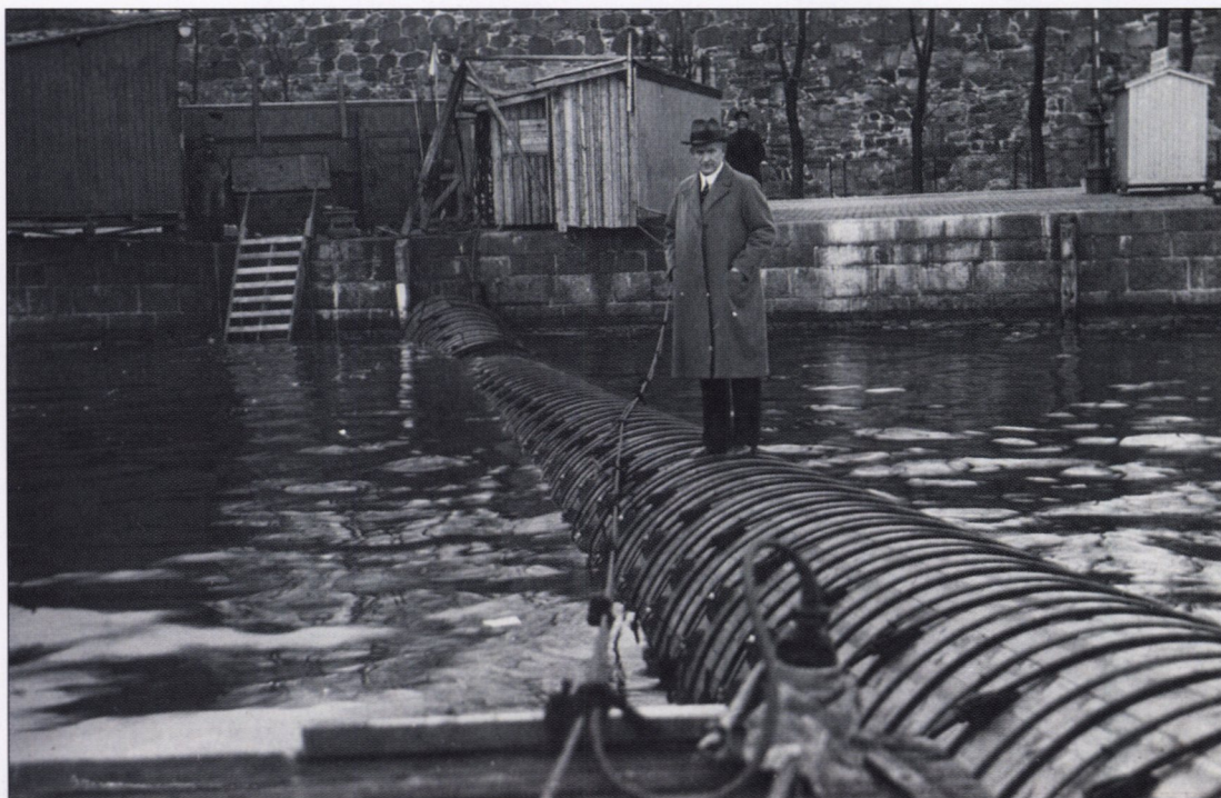
Vannverkssjef Ove Owe på utslippsrøret fra Festningen renseanlegg før nedsenking.
