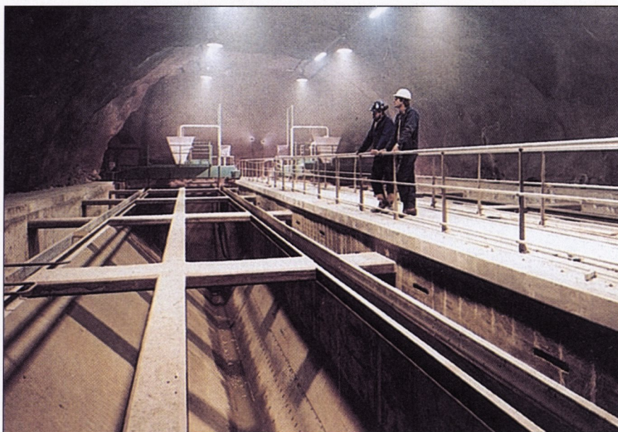
Sandfanget på VEAS før det fylles opp med vann. Det er store dimensjoner på anlegget. Totalt dekker hallene et areal tilsvarende 5 1/2 fotballbane.
