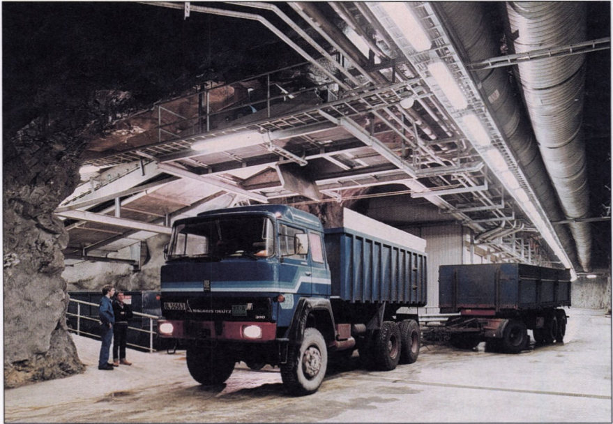
Opplasting av tørket slam. Det kjøres ut 3 til 4 lass, totalt ca. 100 tonn slam pr. dag.
