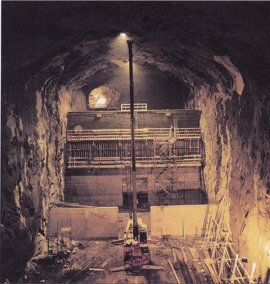
Fra bygging av nye Bekkelaget ra. Hallene er 20m brede, og de dypeste, som her, 24m fra hvelv til bunn.
