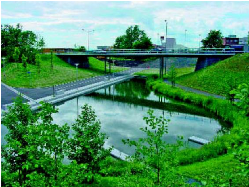
Figur 6.2. Vått overvannsbasseng på Fornebu (Statsbygg, 2004)
