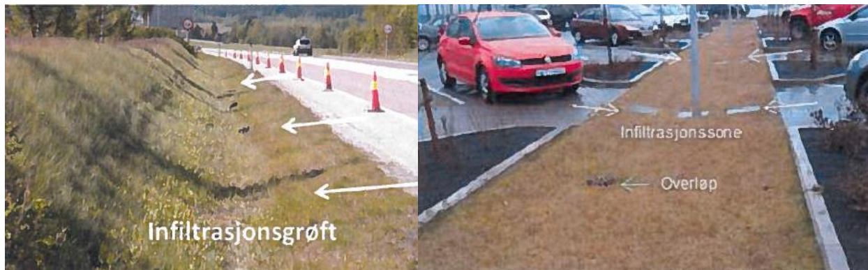
Figur 6.4. Eksempel på infiltrasjonsområder i tilknytning til vei og infiltrasjonssone i tilknytning til en parkeringsplass
